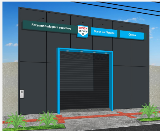
Fachada totalmente revestida em ACM
